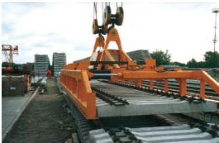
Beton-schwelgenreifer für 30 Schwellen unterschiedlicher Länge
